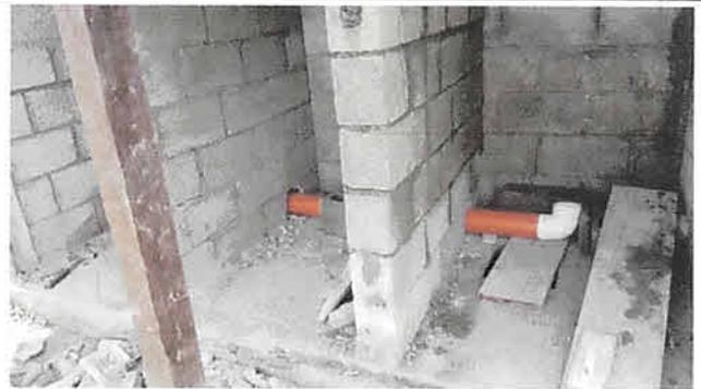
Foto 4: SUSTITUCION DE SANITARIOS E INSTALACION DE DRENAJE
