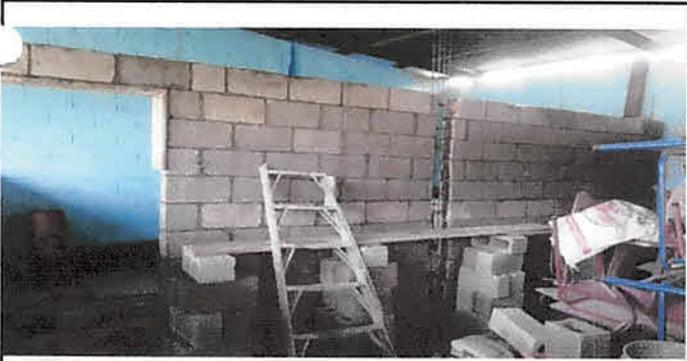
Foto 5: LEVANTADO DE PARED EN AULA PARA SER USADO COMO BODEGA
